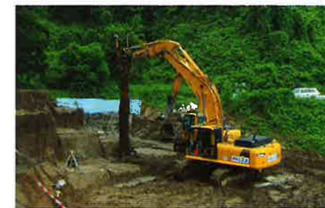
トンネル出口坑口部における改良施工
