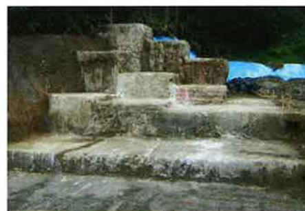
■改良体掘削後出来形
